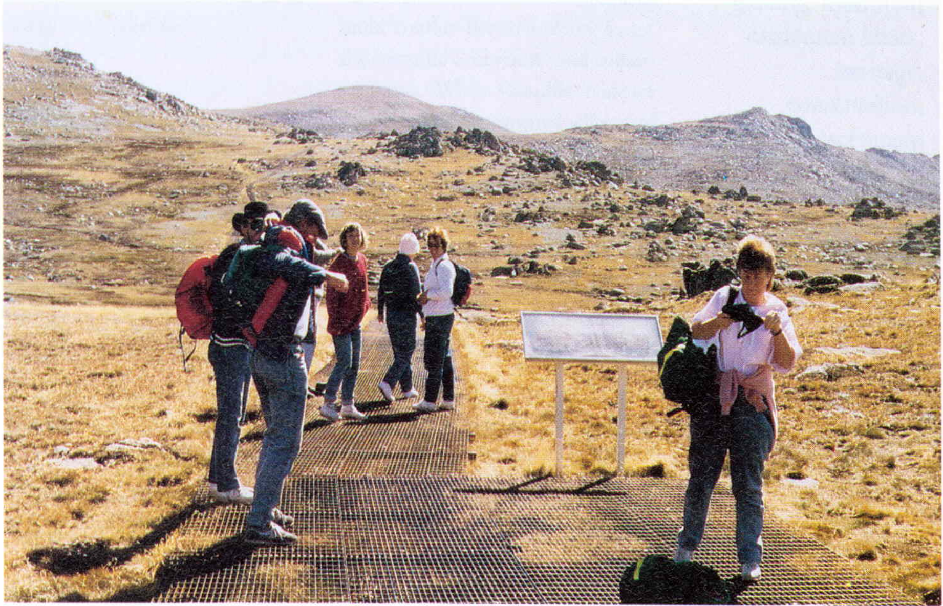
Le sentier métallique surélevé installé pour atténuer l'érosion due au passage des touristes dans le secteur du Mont Kosciuszko. The raised steel walkway constructed to alleviate damage to and erosion of recreational walking tracks in the Mount Kosciuszko area
